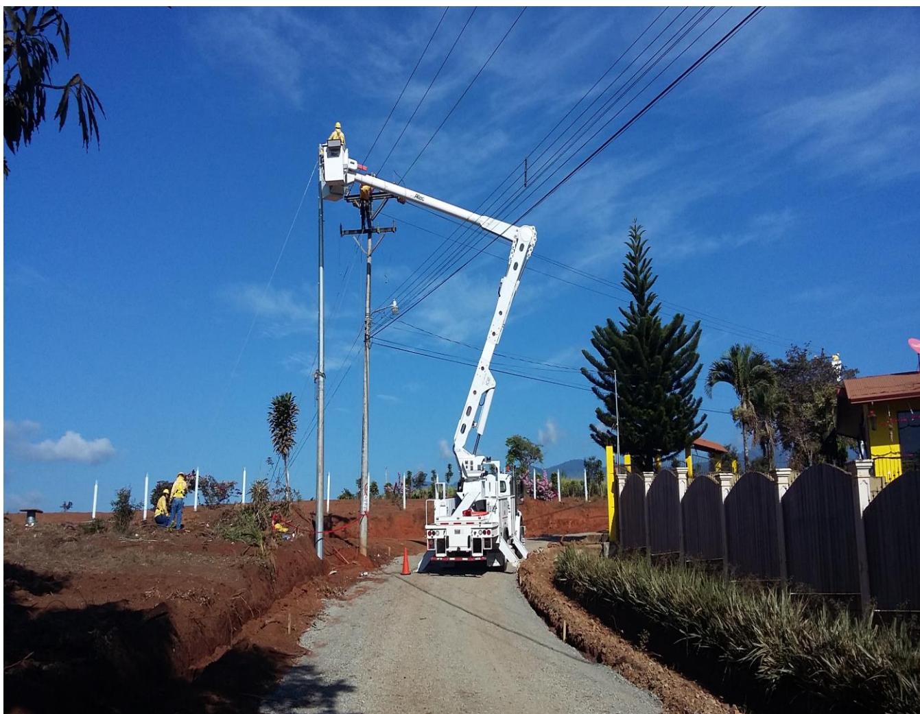
Foto N°.5 Municipalidad de Pérez Zeledón Trabajos de reubicación de postes de líneas de distribución eléctrica por parte del ICE, en la Comunidad de Barrio 8 de Diciembre, Distrito de San Isidro.
