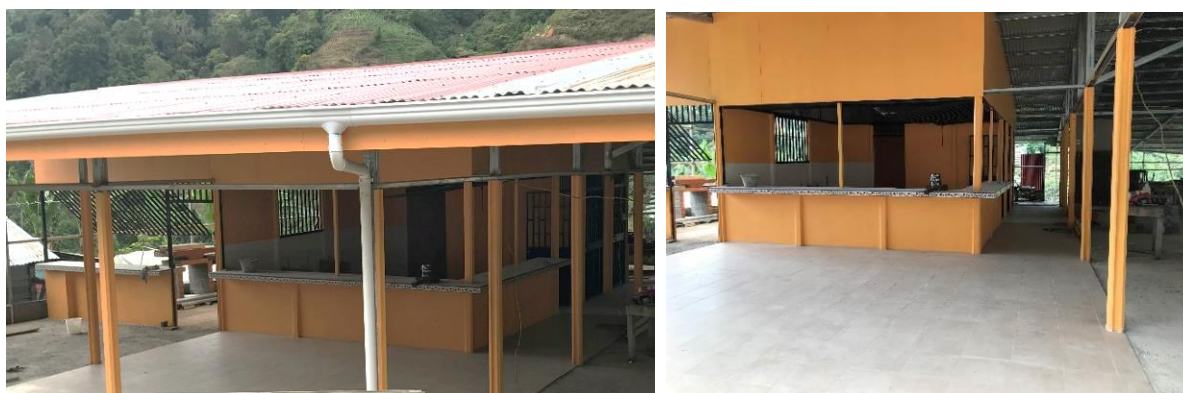
Una vez finalizadas las obras.
