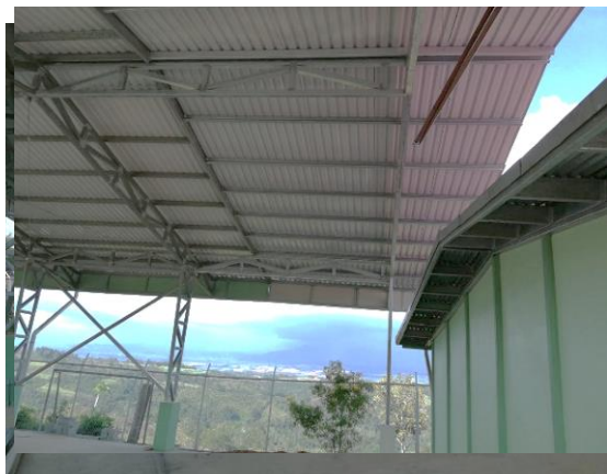
Ampliación cocina del redondel de San Rafael de Platanares.
