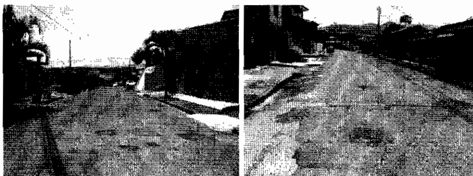
Calle 50 metros norte de ferretería Xiomara, calle a cruce B. Boston, San Isidro.
