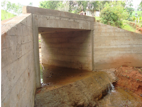
Puente Caja San Salvador, Barú
