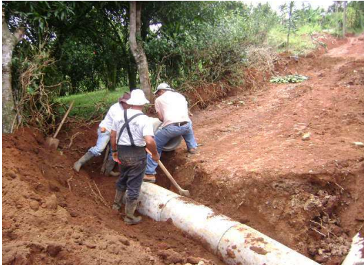
Alcantarillado Calle Luis Abarca
