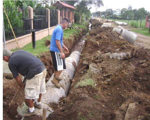
II etapa alcantarillado Barrio Lourdes
