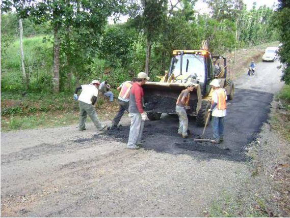
Bacheo Asfáltico Baidambú, Daniel Flores
