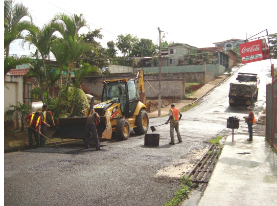
Bacheo Asfáltico Ciudadela Blanco
