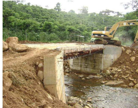
Puente Santiago, San Pedro
