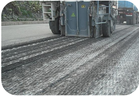
Excavación de capas existentes
