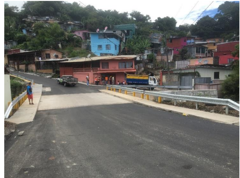
Después de la intervención
