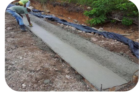
Construcción de cordón y cuneta
