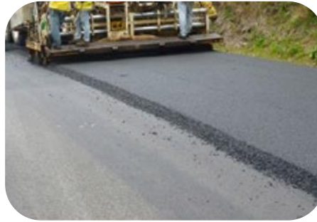
Colocación de bases y capa asfáltica
