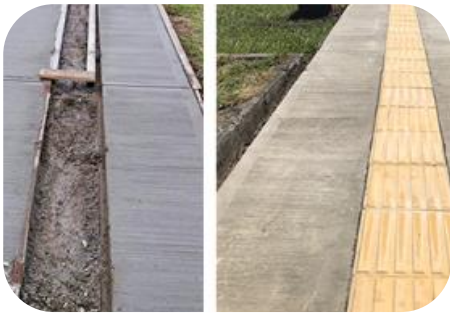
Construcción de aceras
