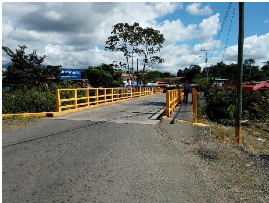
Puente actual sobre río Quebradas. Herrera, 2020.
