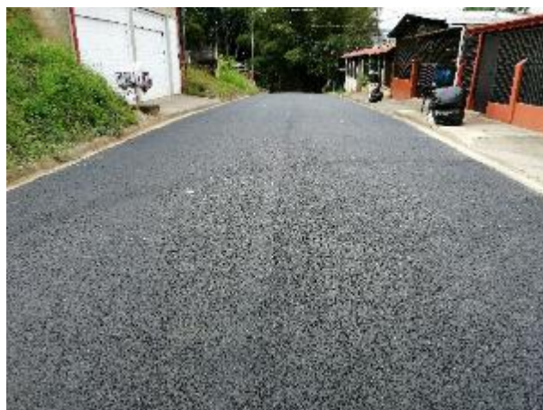
Fotografías 8 y 9 Calle Ciudadela Blanco Colocación de mezcla asfáltica
