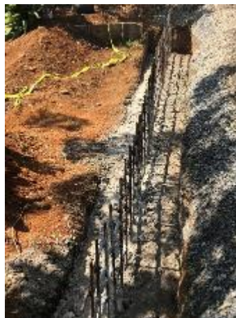
Construcción de canal de concreto y tragantes EST 0+120
