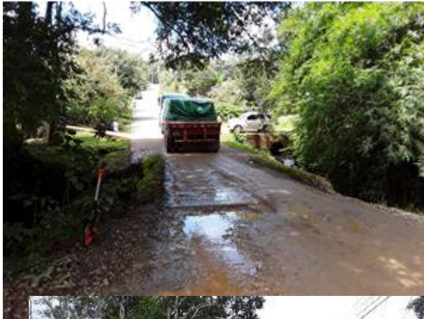
Colocación de mezcla asfáltica
