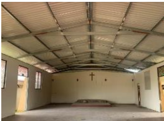
Estado final de la obra
