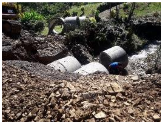
Fotografías N°11 y N°12: Reconstrucción paso alcantarillas, colocación de tubos EST 1+050
