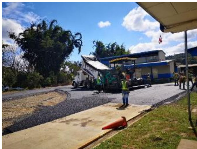
Imagen 2. Proceso de construcción de la vía asfaltada Fuente: Tratamiento de Desechos Sólidos.
