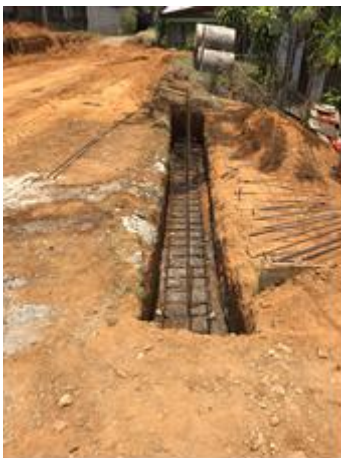
Construcción de canal de concreto y tragantes EST 0+120
