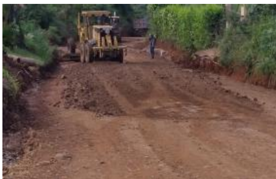
Conformación y colocación de Sub base
