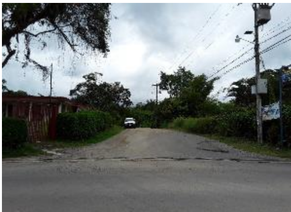
Colocación de mezcla asfáltica
