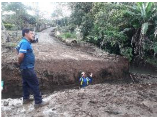
Fotografías N°11 y N°12: Reconstrucción paso alcantarillas, colocación de tubos EST 1+050
