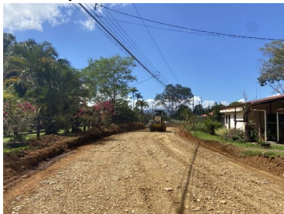
Fotografía N°160 Proyecto Asfalto Santa Elena
