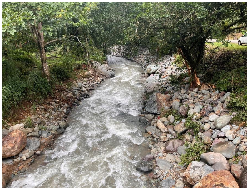
Fotografía 196. Trabajos en río Quebradas, Sector Morazán
