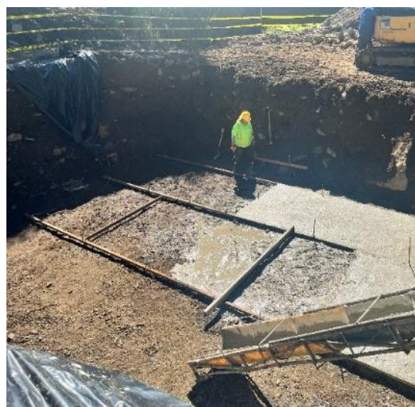
Fotografía N°164 Estado de bastión 1
