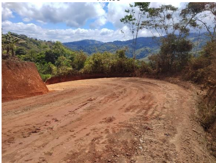
Fotografía N°179 Proyecto Cementado El Ceibo Antes
