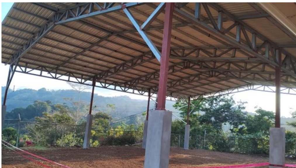
Fotografía N°71 I Etapa Salón multiuso de la Escuela, Los Reyes, Daniel Flores
