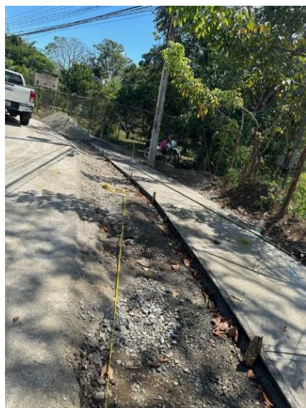
Fotografía N°87 I Etapa construcción de aceras y cunetas caminos C-1-19-0821 Centro, Pejibaye
