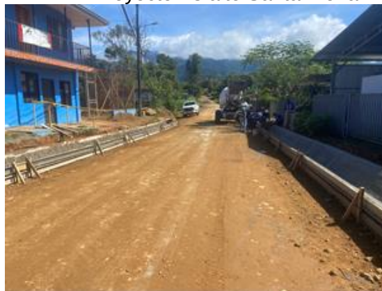
Fotografía N°156 Proyecto Asfalto Santa Elena
