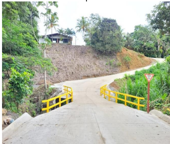
Fotografía N°184 Proyecto Cementado Santa Lucía Después
