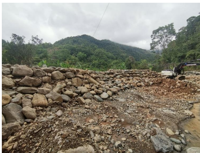
Fotografía 195. Trabajos en el sector de Chucuyo, Rivas
