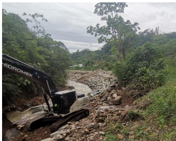
Fotografía 194. Trabajos en el sector de Chucuyo, Rivas
