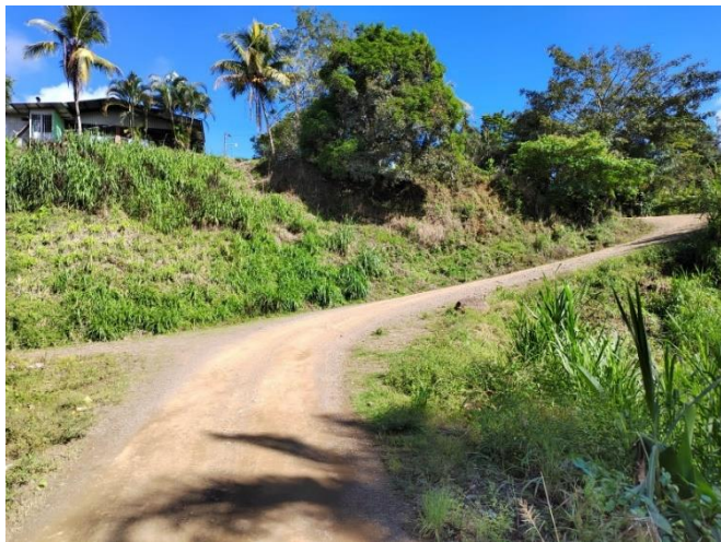
Fotografía N°183 Proyecto Cementado Santa Lucía Antes
