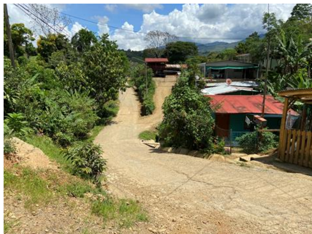
Fotografía N°139 Proyecto Bono comunal Tierra Prometida Construcción de muro de concreto, calle U Antes
