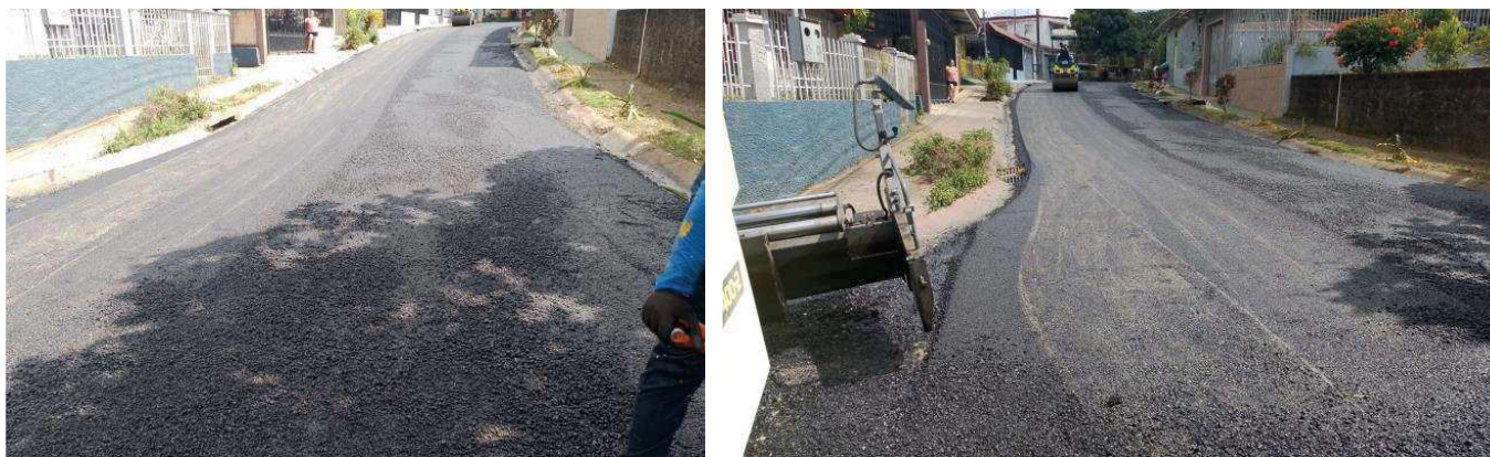
Fotografía N°94 Compra de mezcla asfáltica Calle Moras, Río Nuevo
