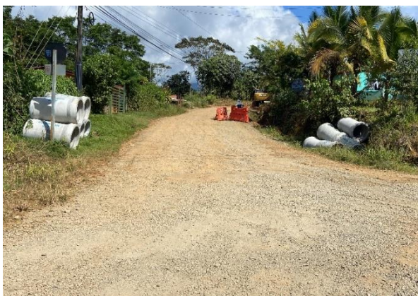
Fotografía N°157 Proyecto Asfalto Santa Elena avenida 2, costado
