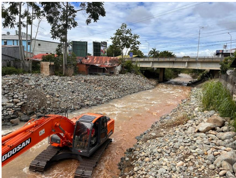
Fotografía 194. Trabajos en el sector Río San Isidro, Sector Fuerza Pública.
