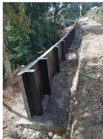
Fotografía N°140 Proyecto Bono comunal Tierra Prometida Construcción de muro de concreto, calle U Después
