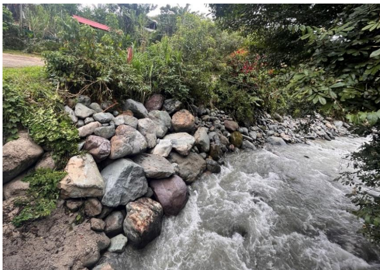
Fotografía 197. Trabajos en río Quebradas, sector puente Quebradas
