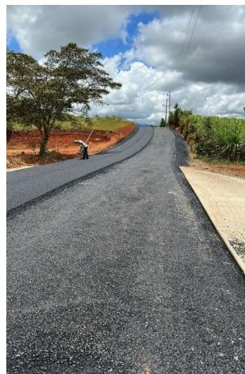
Fotografía N°182 Proyecto Asfaltado Pavones- Cocorí
