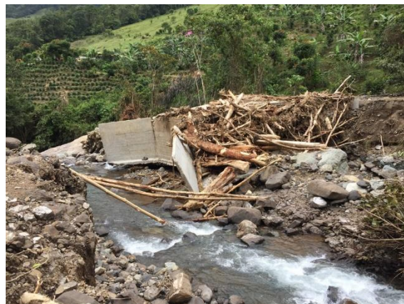
Fotografía N°162 Afectación de Tormenta Nate
