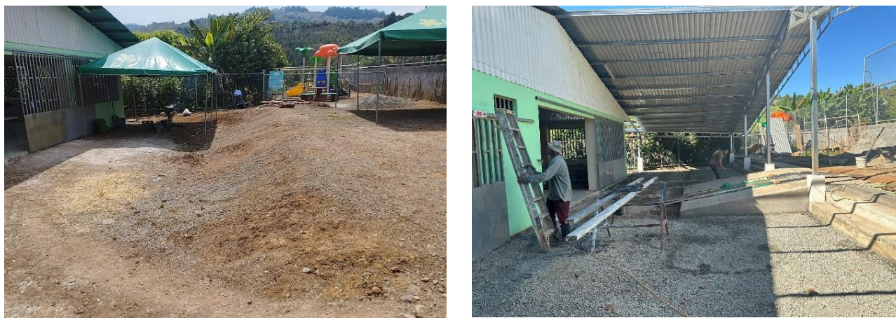
Fotografía N°95 Construcción de anexo cocina comunal San Cayetano, Río Nuevo
