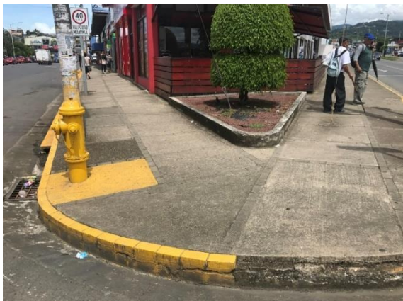
Fotografía N°131 Proyecto Aceras de San Isidro Tramo Salvadoreña -Pizza Hut-Antes
