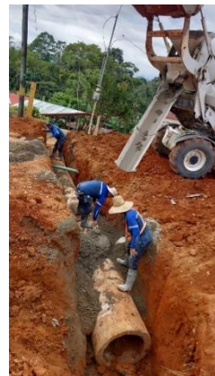
Fotografía N°154 Proyecto Asfalto Santa Elena Paso de alcantarilla reubicado
