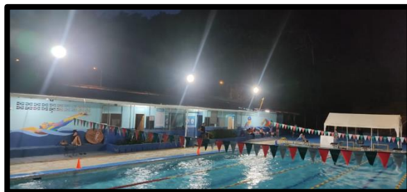
Fotografía N° 52 Iluminación de Piscina, Polideportivo
