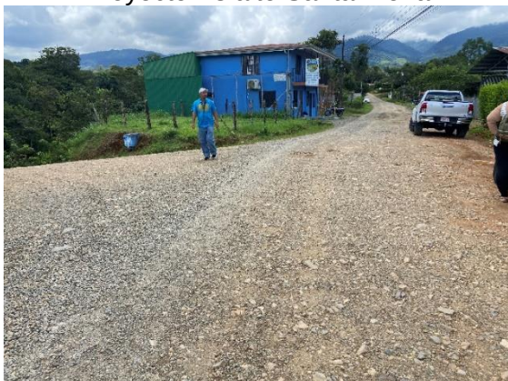
Fotografía N°155 Proyecto Asfalto Santa Elena
