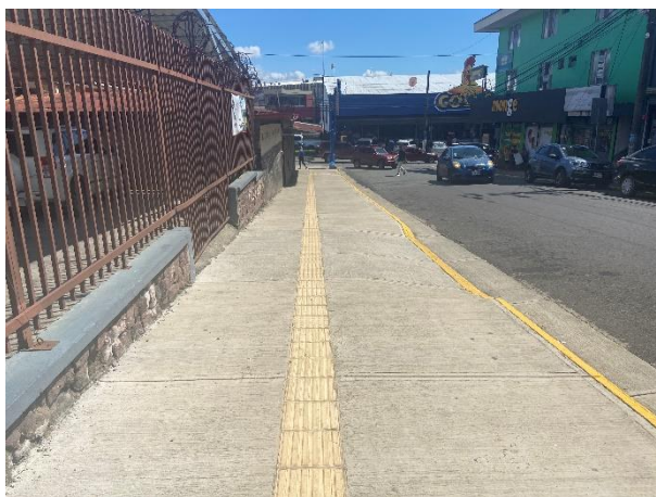
Fotografía N°138 Proyecto Aceras de San Isidro Tramo Lufertzh
