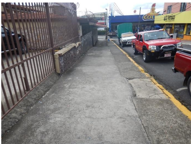
Fotografía N°137 Proyecto Aceras de San Isidro Tramo Lufertzh
