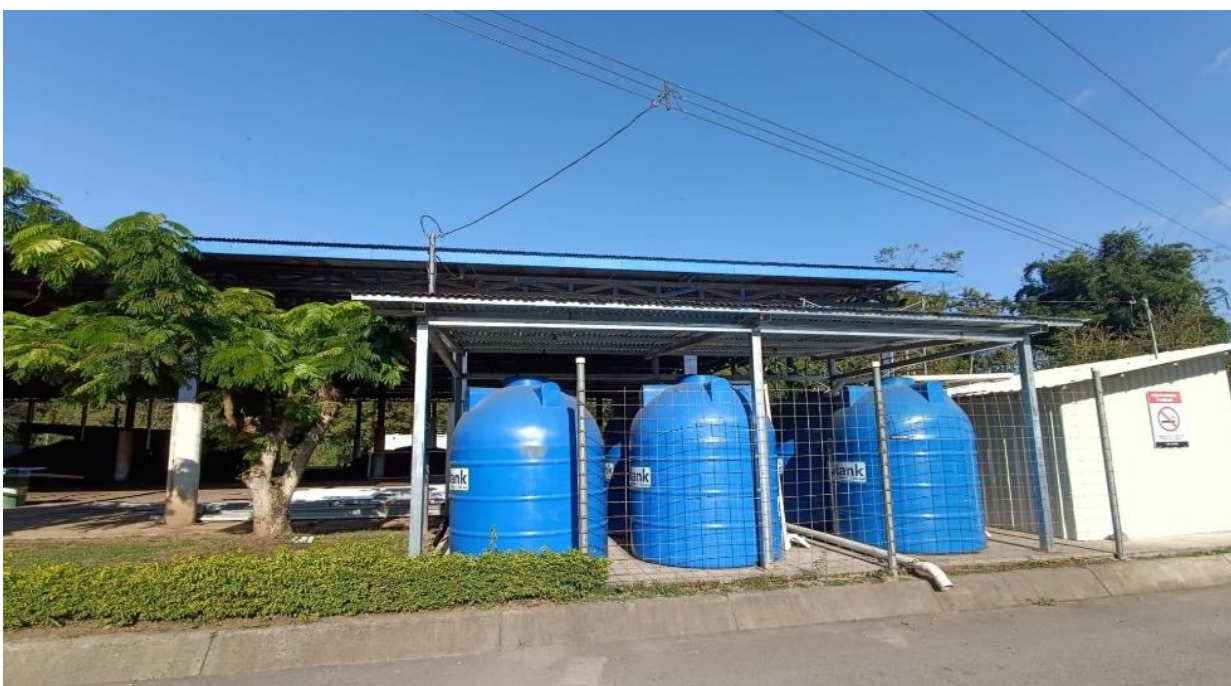
Fotografía N° 37 Municipalidad de Pérez Zeledón Mejoras en las instalaciones de la Planta de Trasferencia
