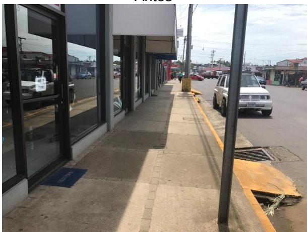
Fotografía N°133 Proyecto Aceras de San Isidro Tramo Salvadoreña -Pizza Hut Antes
