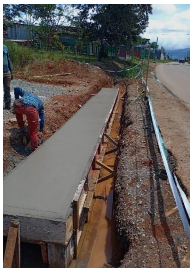
Fotografía N°181 Proyecto Asfaltado Pavones- Cocorí
