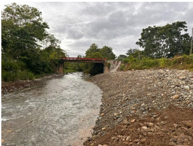
Fotografía 195. Trabajos en el sector Río San Isidro, Sector Puente Rojo
