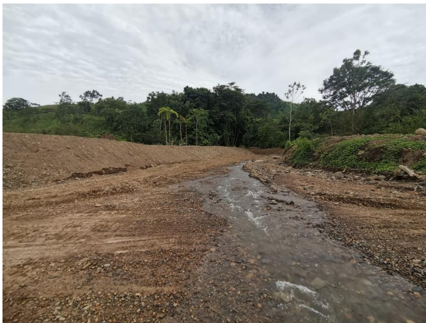
Fotografía 192. Limpieza de camino y cauce
