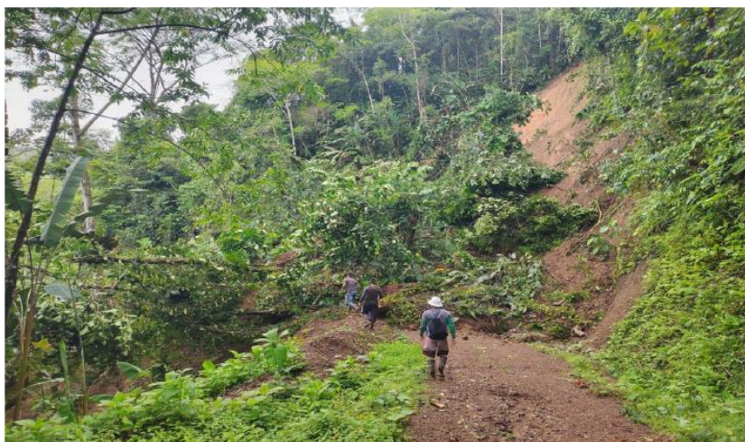
Fotografía 190. Trabajos en el sector de Piedras Blancas de Río Nuevo.
