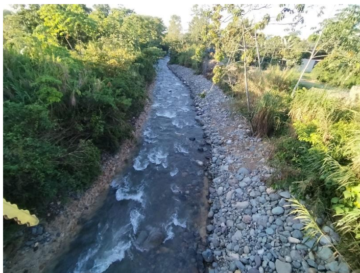
Fotografía 199. Trabajos en el sector de Gravilias, San Andrés
