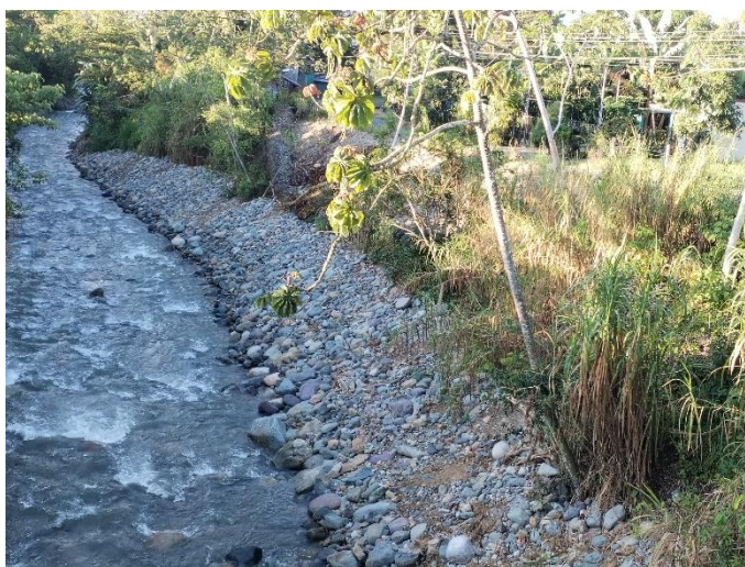
Fotografía 198. Trabajos en el sector de Gravilias, San Andrés
