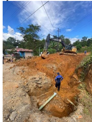
Fotografía N°158 Proyecto Asfalto Santa Elena
