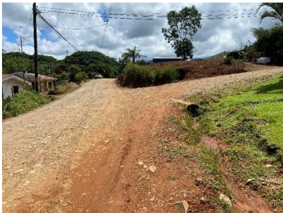
Fotografía N°153 Proyecto Asfalto Santa Elena Paso de alcantarilla a remover
