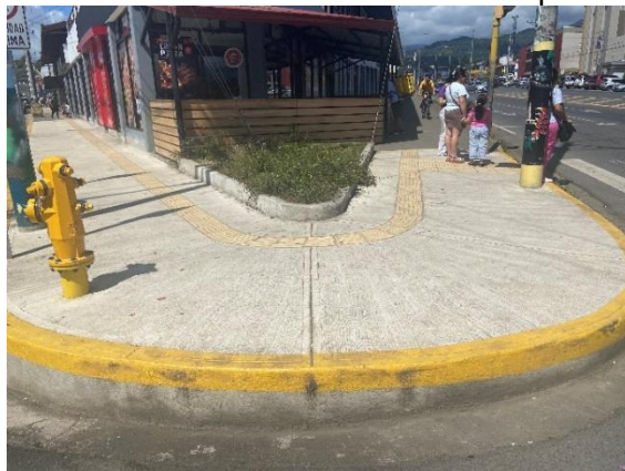
Fotografía N°132 Proyecto Aceras de San Isidro Tramo Salvadoreña-Pizza Hut-Después
