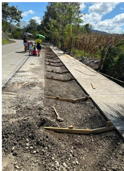
Fotografía N°87 I Etapa construcción de aceras y cunetas caminos C-1-19-0821 Centro, Pejibaye
