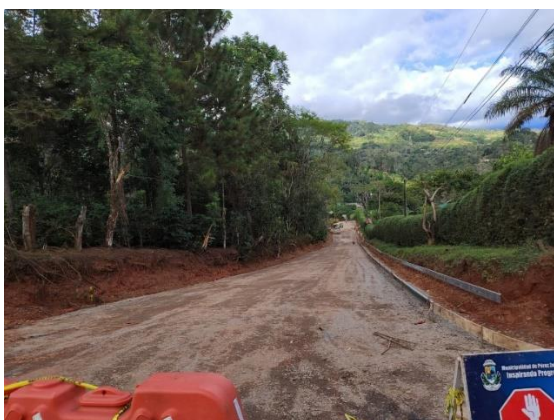
Fotografía 173. Proyecto antes de ser realizado
