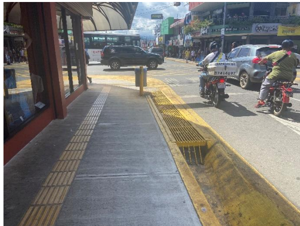
Fotografía N°136 Proyecto Aceras de San Isidro Tramo Salvadoreña -Pizza Hut
