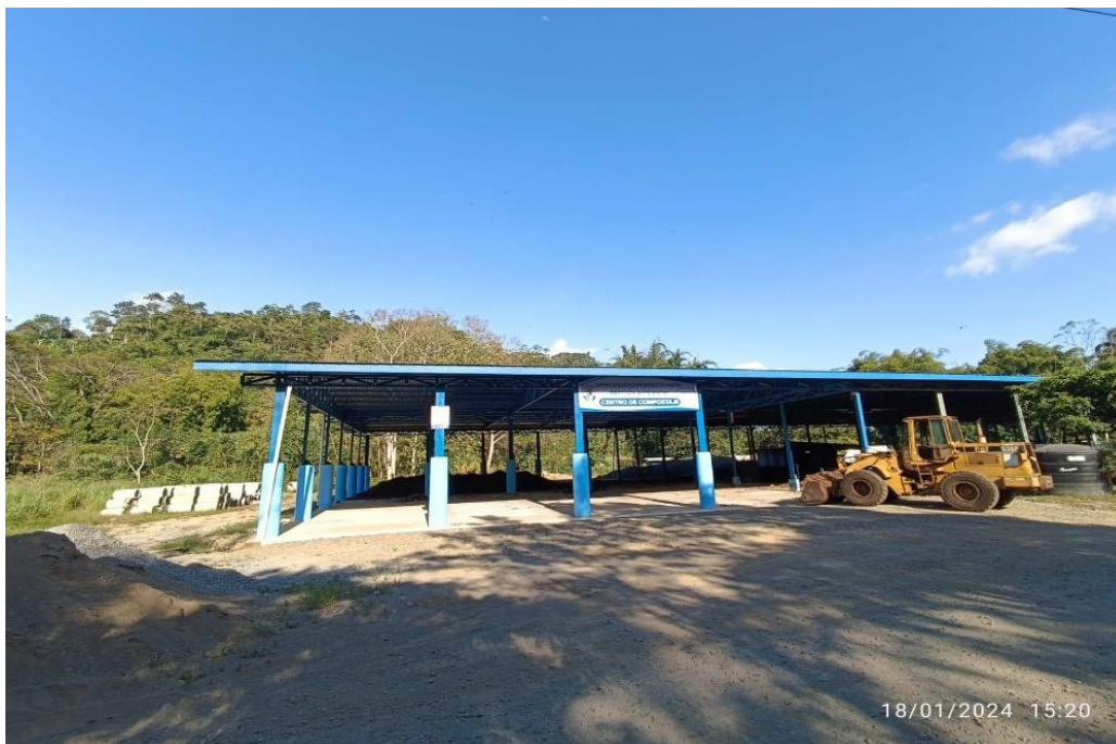
Fotografía N°38 Municipalidad de Pérez Zeledón Mejoras en las instalaciones de la Planta de Trasferencia
