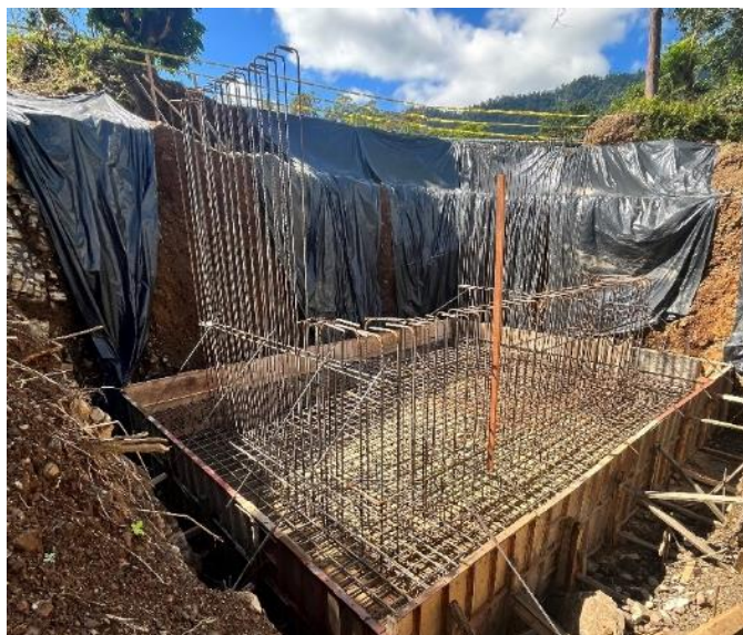
Fotografía N°163 Estado de bastión 2
