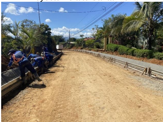
Fotografía N°159 Proyecto Asfalto Santa Elena
