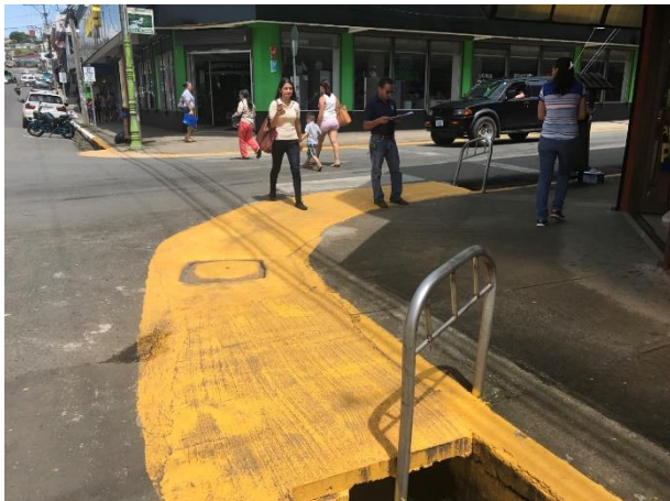
Fotografía N°135 Proyecto Aceras de San Isidro Tramo Salvadoreña -Pizza Hut
