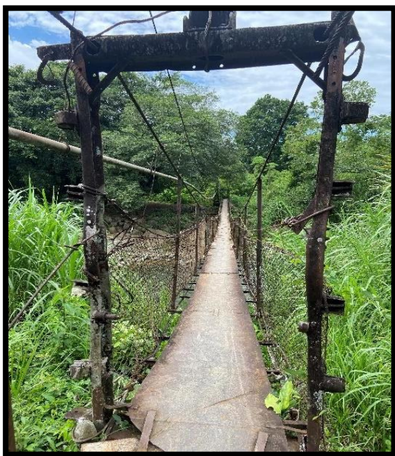
Fotografía N°55 Proyecto Puente Arenilla
