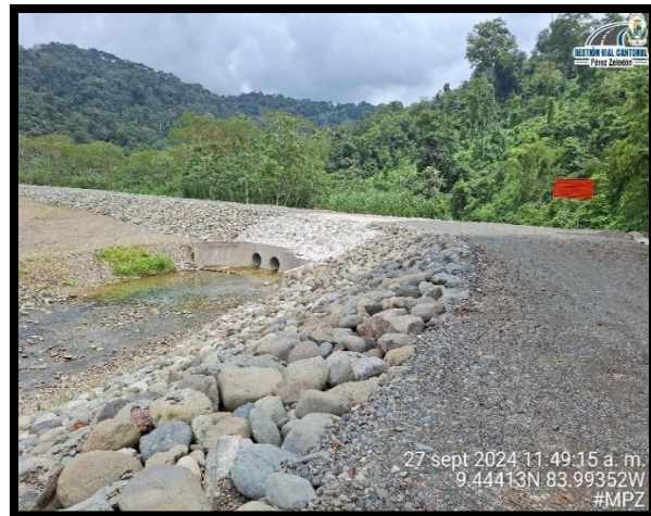
Fotografía N° 80 Dique Rafiki Después
