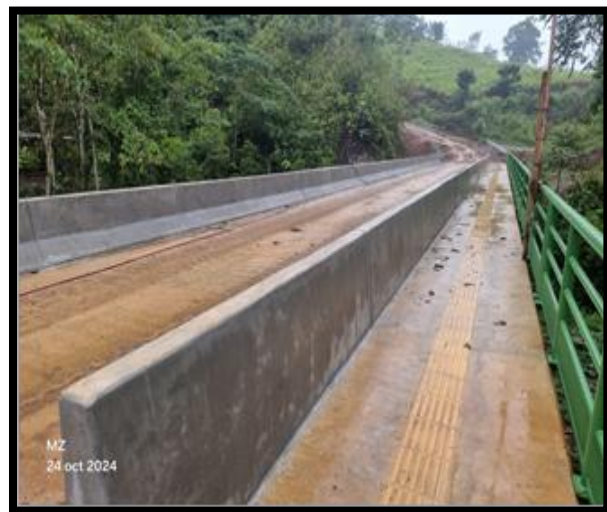
Fotografía 64 Puente Zapotal, Zaragoza, Después
