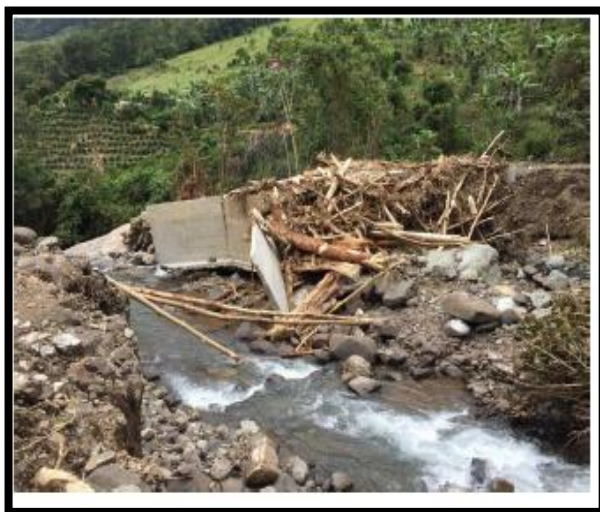
Fotografía 63 Puente Zapotal, Zaragoza Antes
