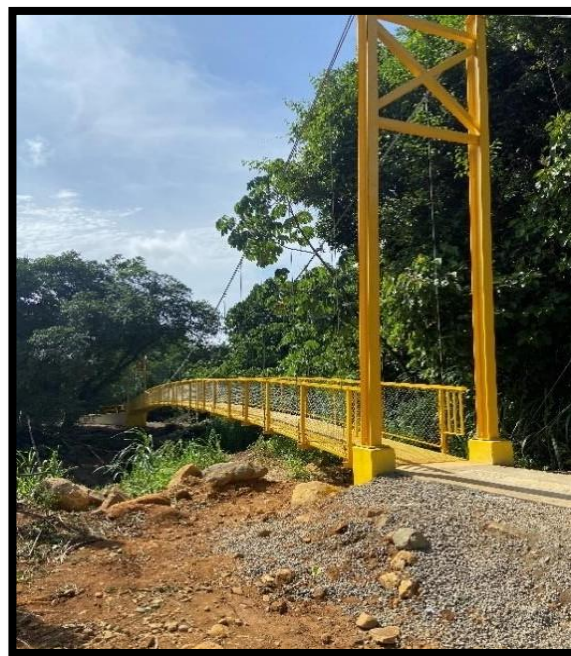
Fotografía N°56 Proyecto Puente Arenilla
